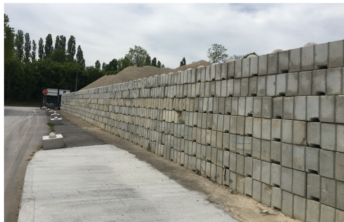
Figure 15 : Mur de BOPLO® mis en place sur l'activité recyclage des matériaux et déchets issus du BTP
