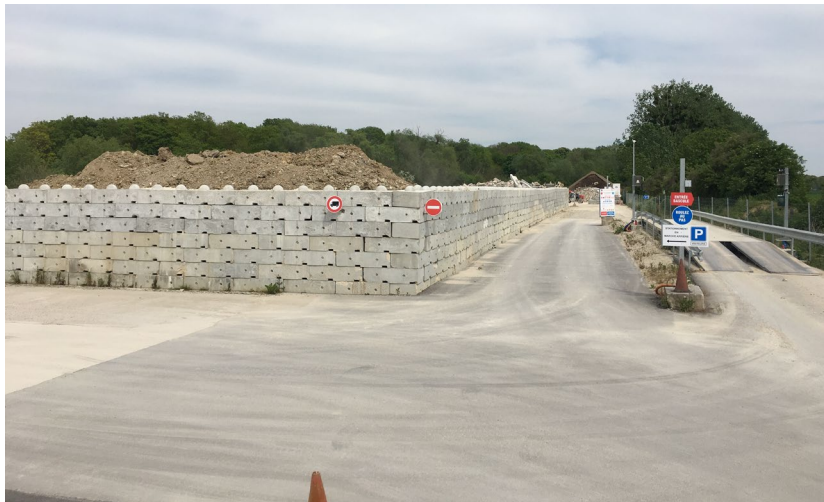
Figure 17 : Mur de BOPLO® mis en place sur l'activité activité Terres Fertiles®
