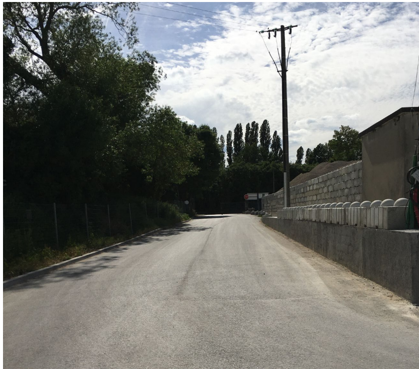
Figure 3 : Travaux réalisés à l'entrée du site
